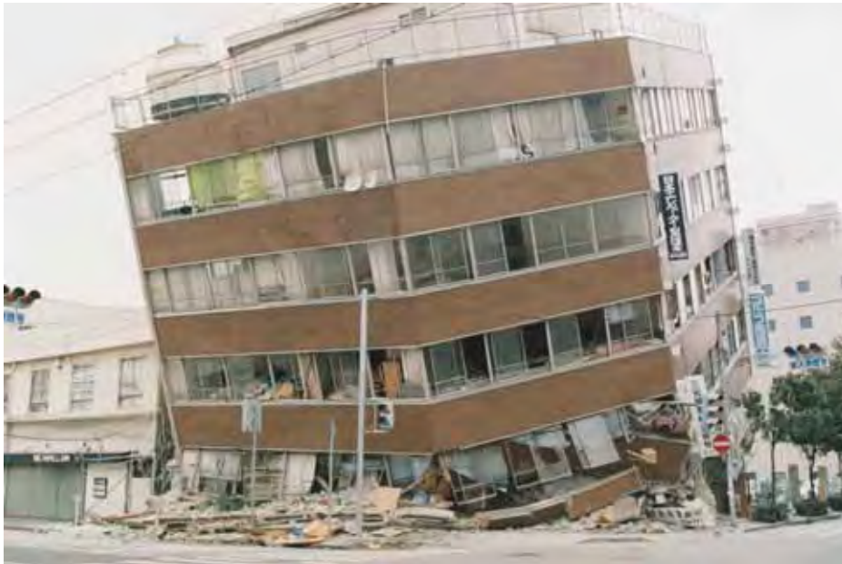
阪神大震災により倒壊した建物
